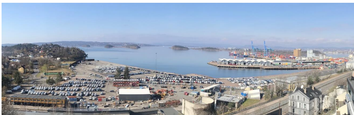
Bilde av dagens situasjon med parkerte biler spredt over hele havnearealet fra Ormsundkaia til og med Kneppeskjær.
