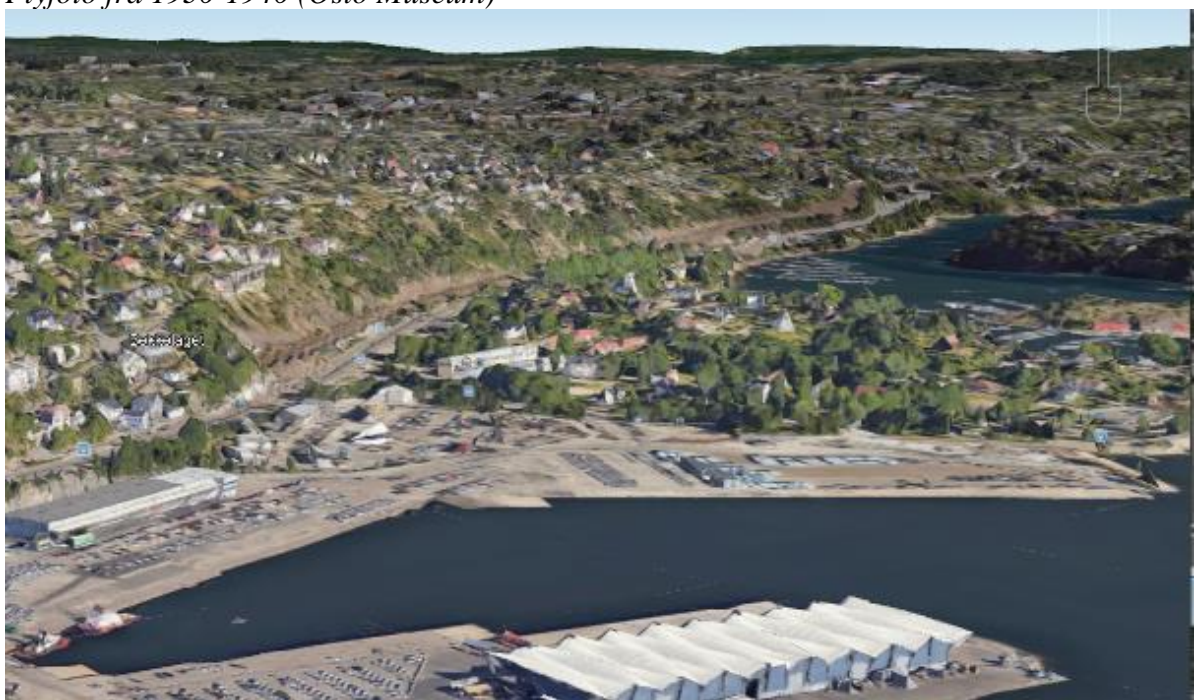
Dagens situasjon (Google Earth)
